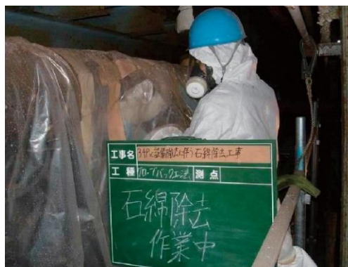
図 4.10.9 石綿除去作業中 1
