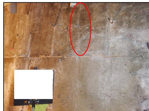
図4.15.10 取り残しの除去の確認
