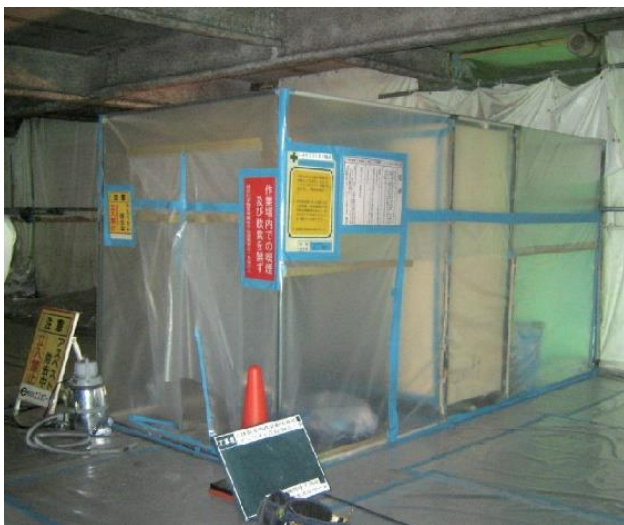
図 4.7.28 セキュリティゾーン外観
