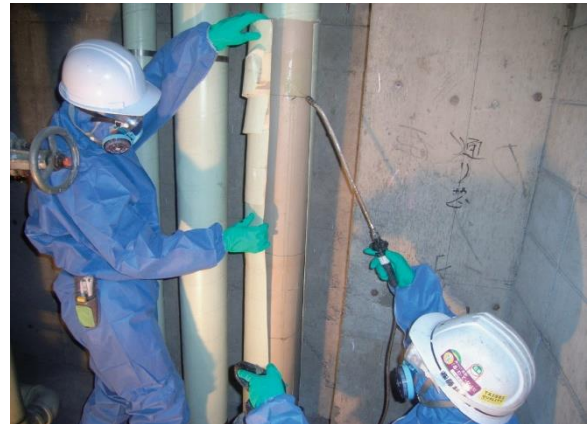
図 4.8.3 保温材の湿潤化→取り外し
