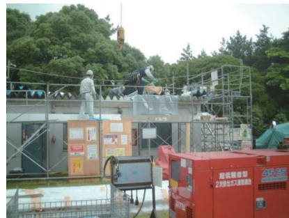
図 4.10.17 折板をはがしているところ
