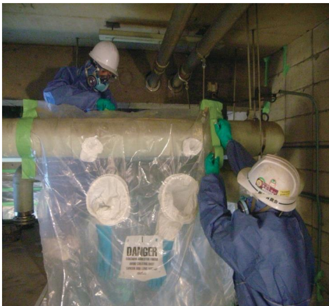
図 4.10.1 グローブバッグの例
