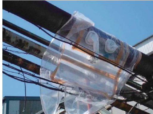
図 4.10.3 切断箇所へのグローブバッグ取付
