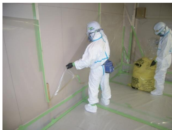
図 4.7.91 隔離シートの撤去
