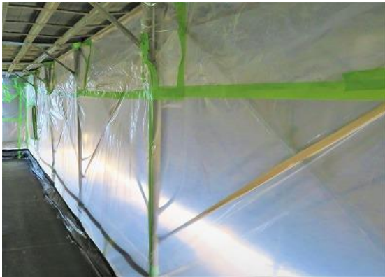
周囲への飛沫飛散防止養生例（内部）
