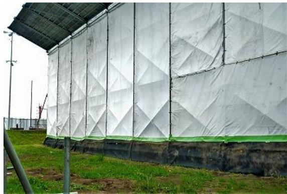
周囲への飛沫飛散防止養生例（外部）
