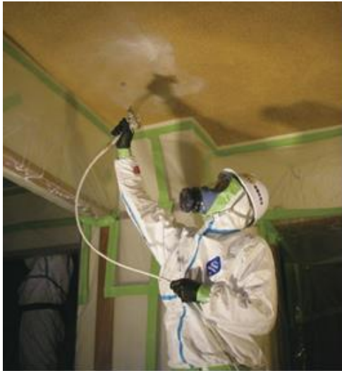
図 4.7.69 粉じん飛散抑制剤の散布による湿潤化
