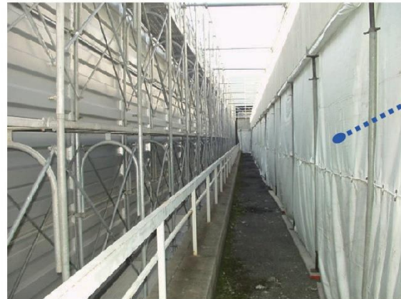
図 4.7.19 外壁開口部の飛散防止措置（開口部全面に防災シートを張った）
