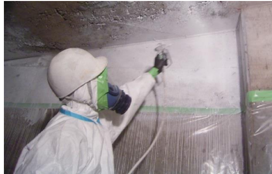
図 4.7.73 除去した後の下地面への粉じん飛散防止処理剤の散布
