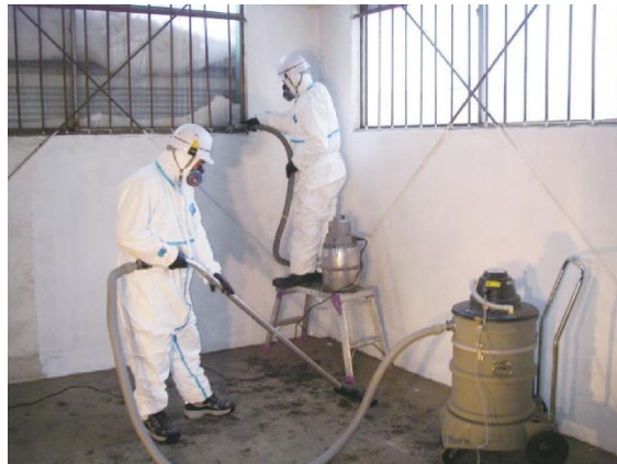
図 4.7.92 高性能真空掃除機を用いた作業場内の仕上清掃
