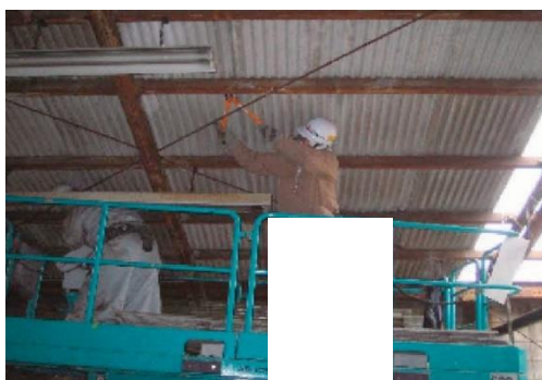
屋根スレート止め金物切断
