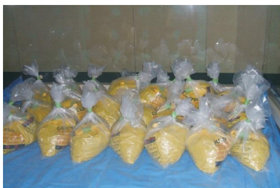
図 4.7.78 除去した石綿廃棄物の保管
