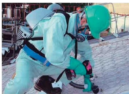
粉じん回収（高性能真空掃除機）
