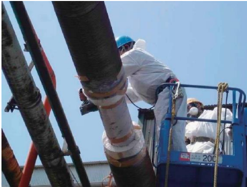
図 4.10.4 切断箇所の保温材除去と養生
