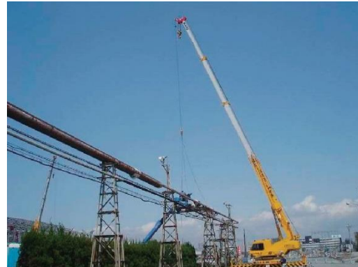
図 4.10.5 配管の吊り下ろし
