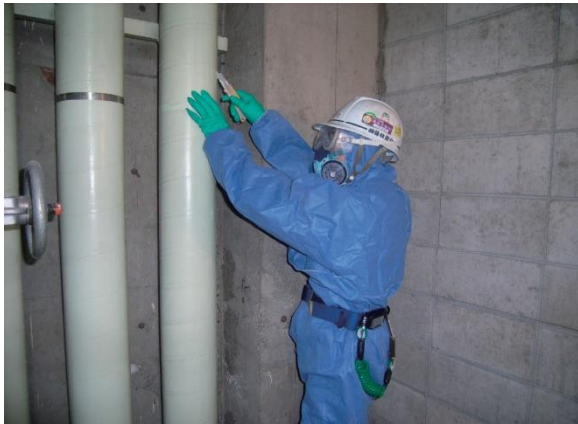
図 4.8.2 保温材被覆撤去
