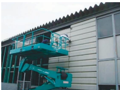
壁金物取外し
