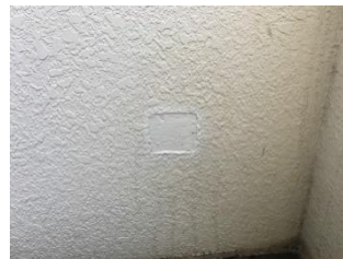
(固化および簡易補修後)
