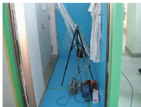
図 4.7.8 同左施工区画 (内部)
