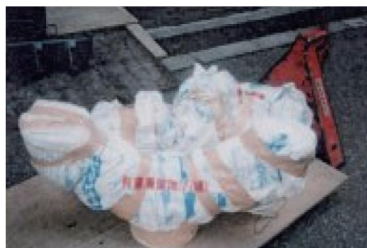
図 4.8.7 除去した石綿含有保温材付配管を梱包し、廃石綿等として処理した例 (廃棄にあたっては石綿を含む廃棄物が入っていること及び取扱い注意事項を表示する。)
