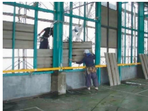
壁石綿含有成形板取外し
