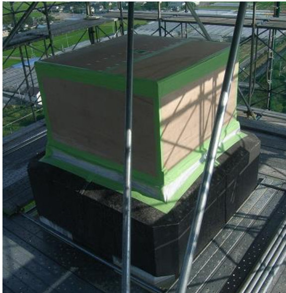
図 4.7.34 煙突開口部養生例
