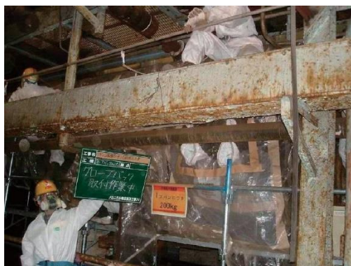
図 4.10.8 グローブバッグ取付作業中
