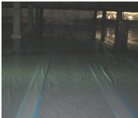
図 4.7.11 床面の負圧隔離養生例 (2重張り)
