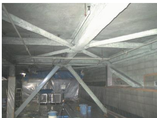
図 4.7.5 同上施工区画の内部側
