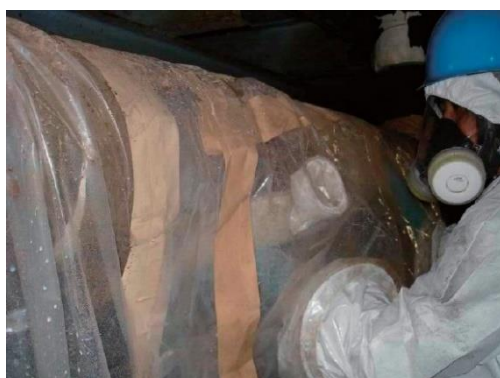
図 4.10.10 石綿除去作業中 2
