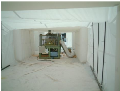
図 4.10.16 吊り下ろした折板を局所排気装置付切断機で切断するための切断ブース
