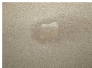
(飛散防止剤にて固化)
