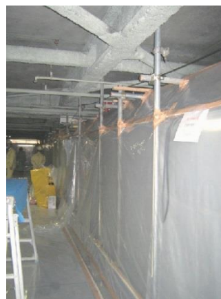
図 4.7.6 同上施工区画 (内部側、右外側が車路)
