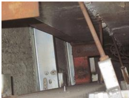
（参考資料）写真6-10 カーテンウォール 裏打ち断熱材
