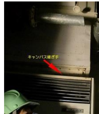
（参考資料）写真6-11 キャンバス継ぎ手
