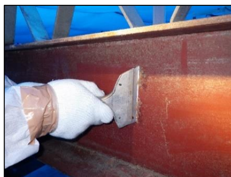
図4.15.5 再付着した石綿の除去
