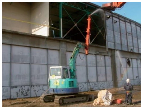
図4.11.5 湿潤化の例 （作業内容に応じて立入禁止措置や掲示を行うこと）
