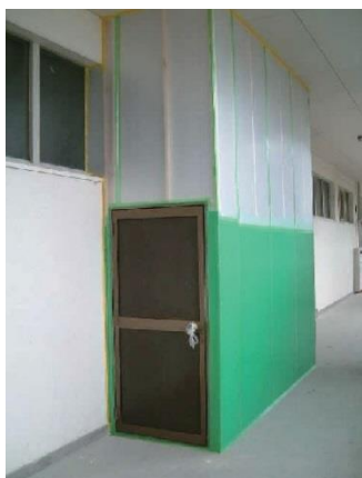
図 4.7.7 教室前廊下の施工区画 (外部側)
