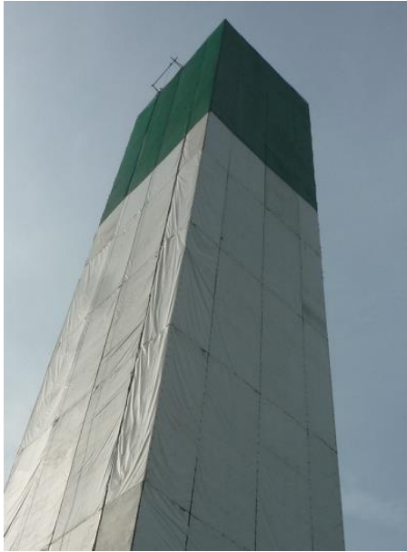
図 4.7.32 垂直ネットによる煙突頂部養生例
