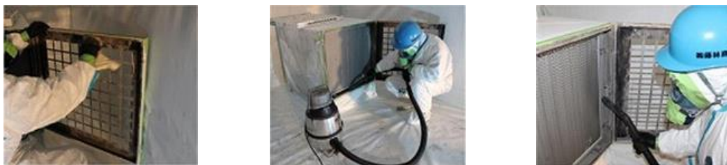
図 4.7.83 HEPAフィルタ等の清掃
