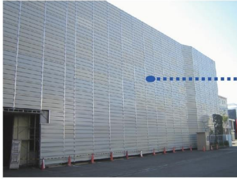
図 4.7.17 建屋周囲に設置した、通常の解体工事で使用する防音パネル（枠組足場に取り付け、内部の石綿除去工事を視覚的にも遮断）
