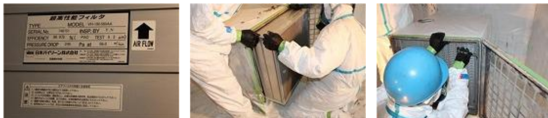
図 4.7.86 フィルタの取り付け
