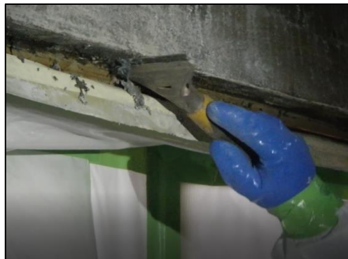
図4.15.7 梁の下の石綿の除去（スクレーパカッター）
