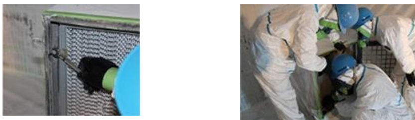
図 4.7.84 HEPAフィルタの留め付の緩み点検
